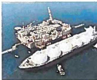
L'impianto di Olt Off Shore
